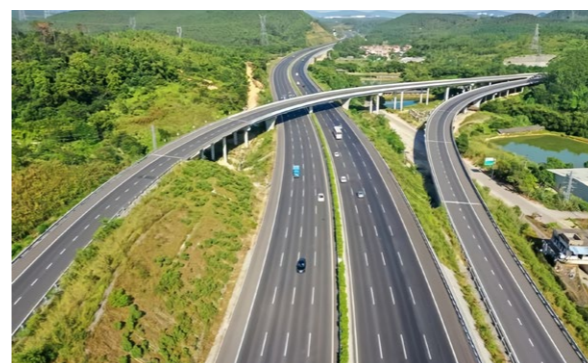
南海至新会高速公路建设项目（136 亿元）
